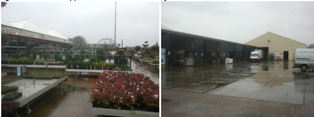
Figuur 5.4: te overkappen terrein aan de noordzijde
