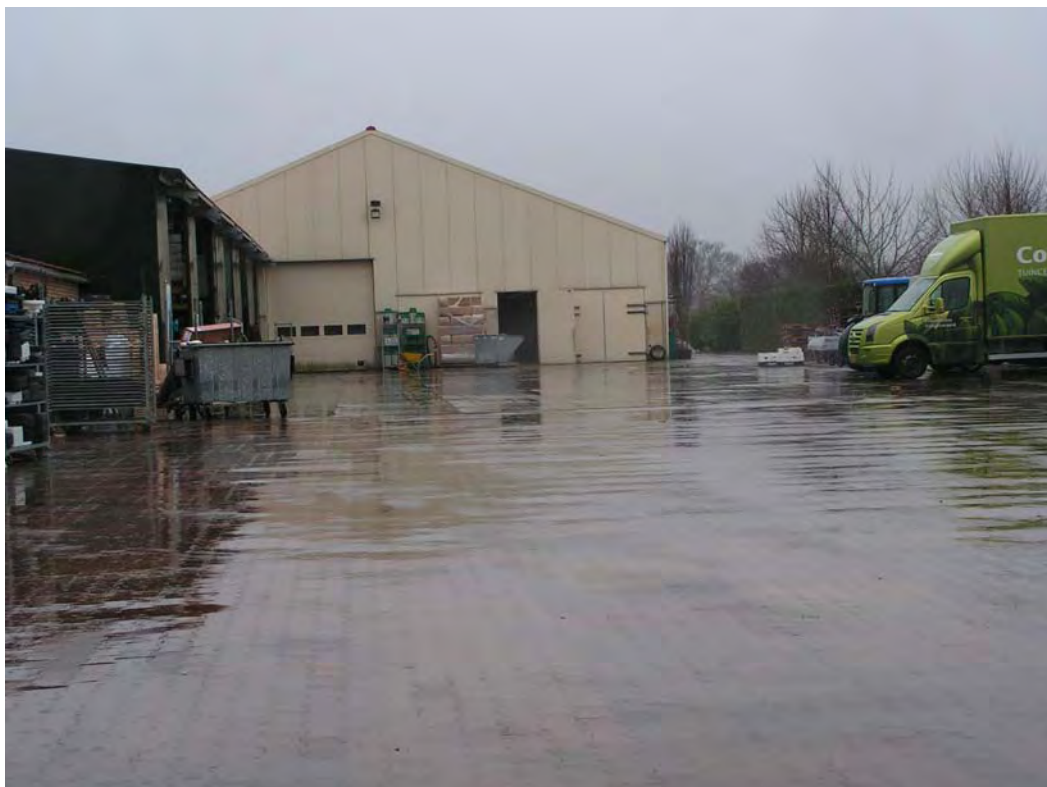
Foto 3. Aanbouw loods westkant
