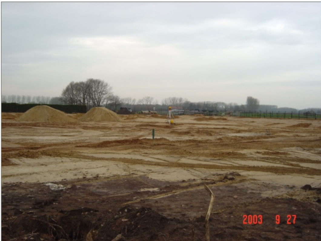
Afb. 7b Foto van de in 2003 uitgevoerde grondwerkzaamheden
