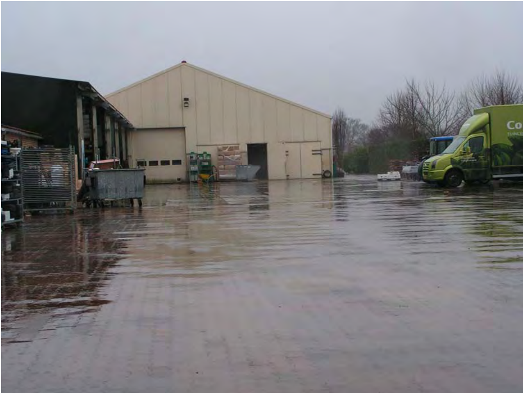
Foto 3. Aanbouw loods westkant
