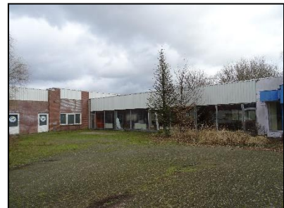
Figuur 5. Noordzijde pand.
