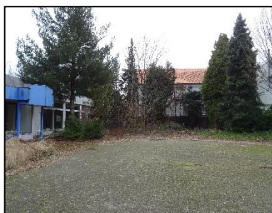
Figuur 7. Noordoostzijde onderzoekslocatie.
