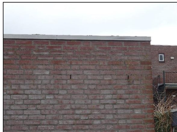
Figuur 26. Ruimte onder daktrim en in open stootvoeg geschikt voor vleermuizen op locatie 3.
