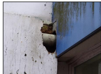
Figuur 16. Ruimte in houten gevelbeplating geschikt als broedplaats huismus en gierzwaluw.
