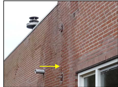
Figuur 19. Ruimte in scheur in gevel geschikt voor vleermuizen.
