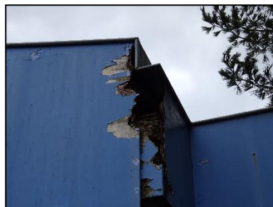
Figuur 15. Ruimte in houten gevelbeplating geschikt als broedplaats huismus en gierzwaluw.
