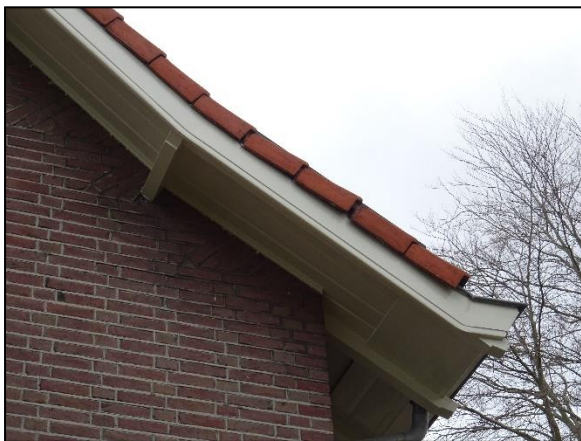
Figuur 23. Ruimte onder overhangende dakpannen geschikt voor vleermuizen op locatie 1.
