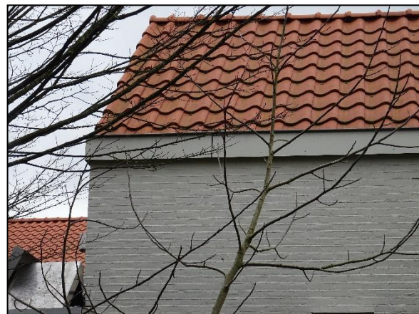
Figuur 24. Ruimte onder betimmering en dakpannen geschikt voor vleermuizen op locatie 2.
