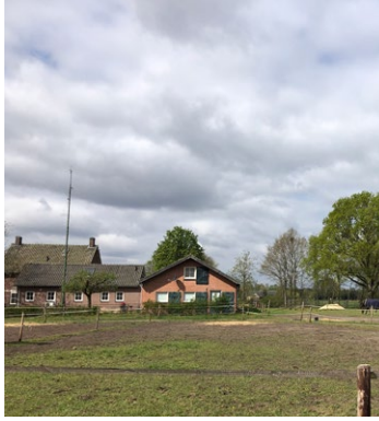
2. te slopen woonhuis met bijgebouw
