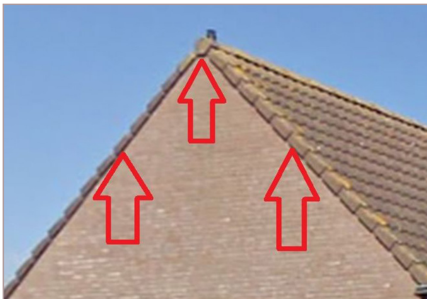
Figuur 3 Voorbeeld van schuine kop- gevel met voor vleermuizen toegankelijke kantpannen.
