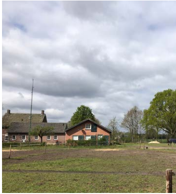
2. te slopen woonhuis met bijgebouw
