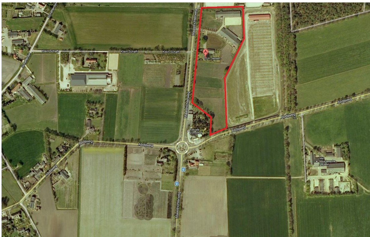
Figuur 3.1: Luchtfoto van de omgeving (het plangebied is omkaderd)
