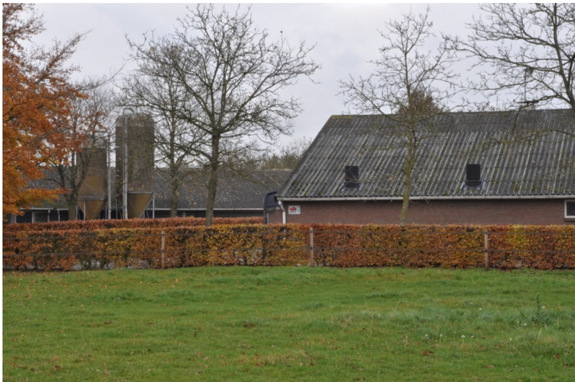
Bestaande varkensstallen welke gefaseerd plaats zullen maken voor de nieuwbouw.
