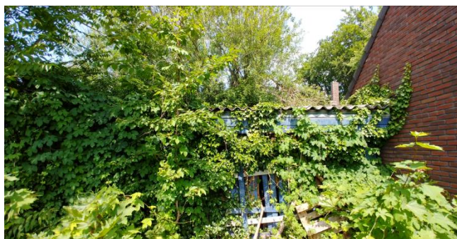
Figuur 8: Opstal tegen de zuidgrens van het plangebied, gezien vanaf de Hofstraat
