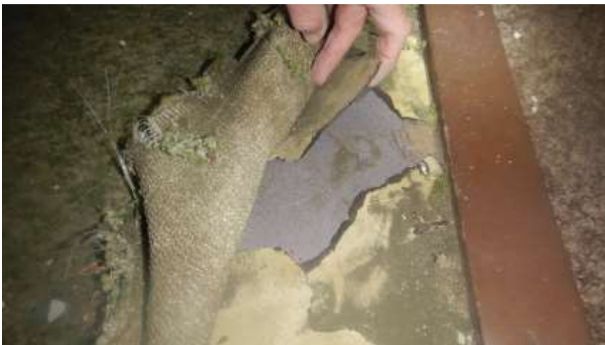
Diverse lagen niet asbest verdacht vloerzeil
