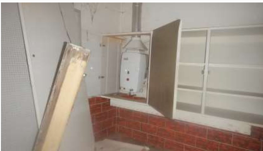
Fasto geiser, asbestvrij
