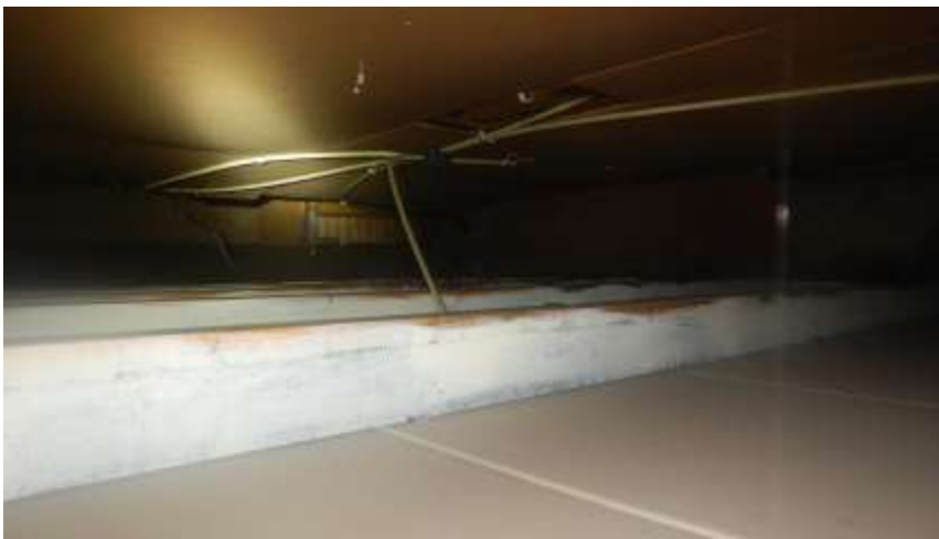
Zachtboard boven gipsplaat plafonds
