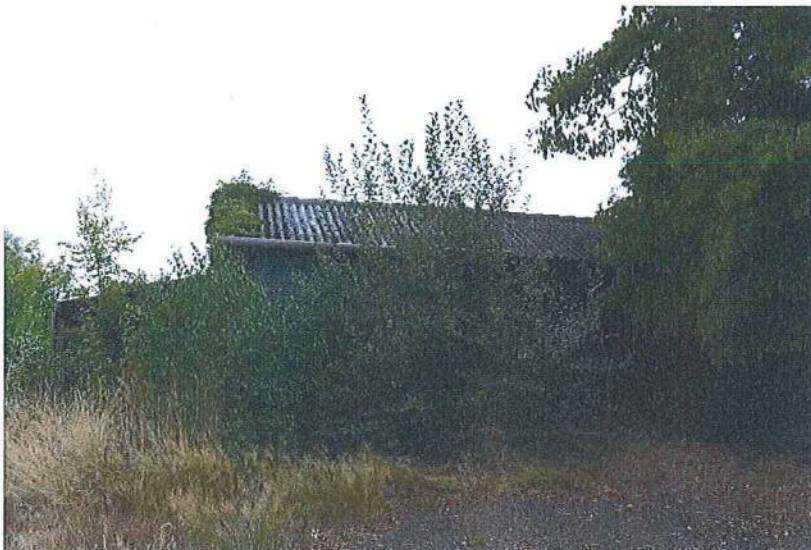
Foto 13: deelgebied 4 – halfopen schuur / machineberging (met golfplaten dak en creosoot palen) gezien vanuit zuid- in noordelijke richting
