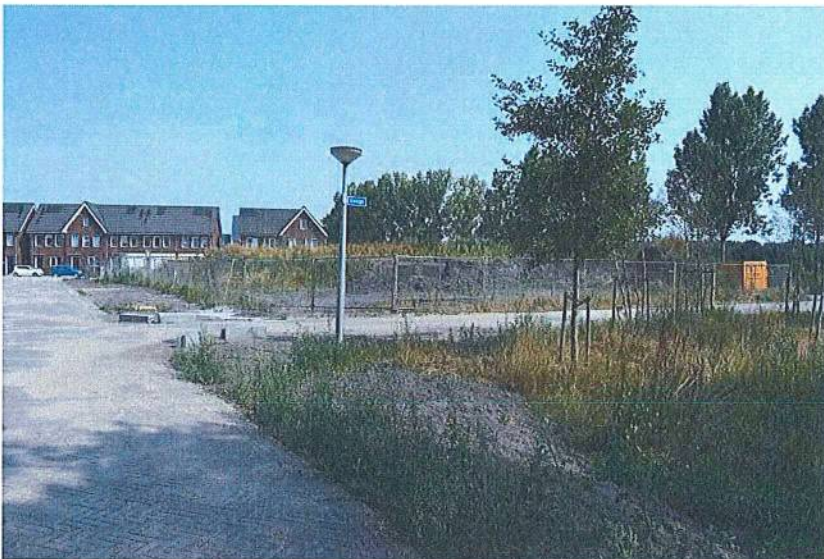
Foto 4: Deelgebied 2 – zuidelijk gedeelte (gronddepot)
