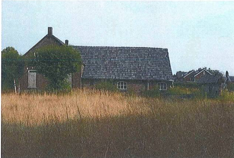
Foto 10: deelgebied 4 - boerderijwoning met achterliggende stalruimte (gezien vanaf de Past. Bolsiusstraat in noordelijke richting)
