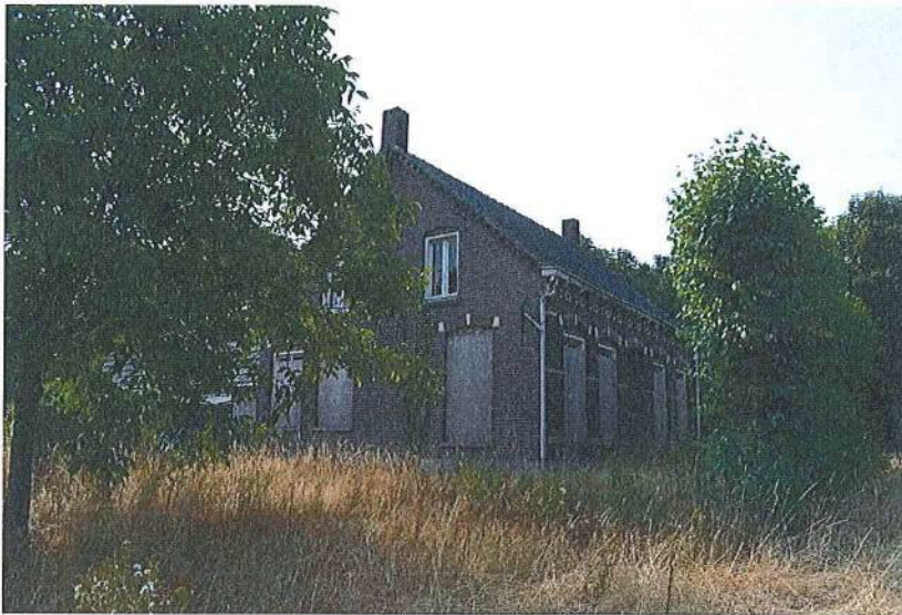
Foto 9: deelgebied 4 - boerderijwoning Mgr. Smetsstraat 29 (gezien vanuit noordwest- in zuidoost richting)
