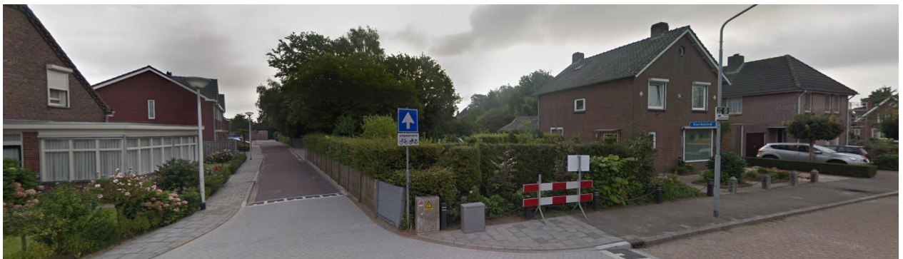
Figuur 4. Bestaande situatie aan de Kerkeind (gezien vanaf de Kerkakkerstraat)
