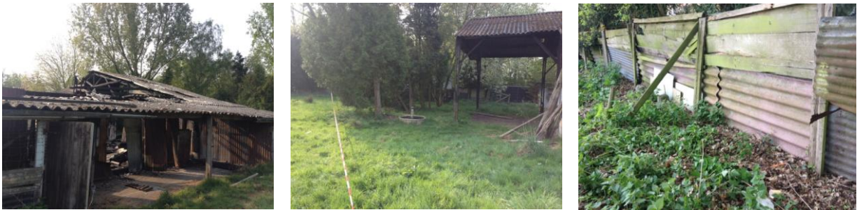
Foto 5 en 6: In het gebied blijven nog asbesthoudende golfplaten aanwezig op het dak van de loods en erfafscheiding.
