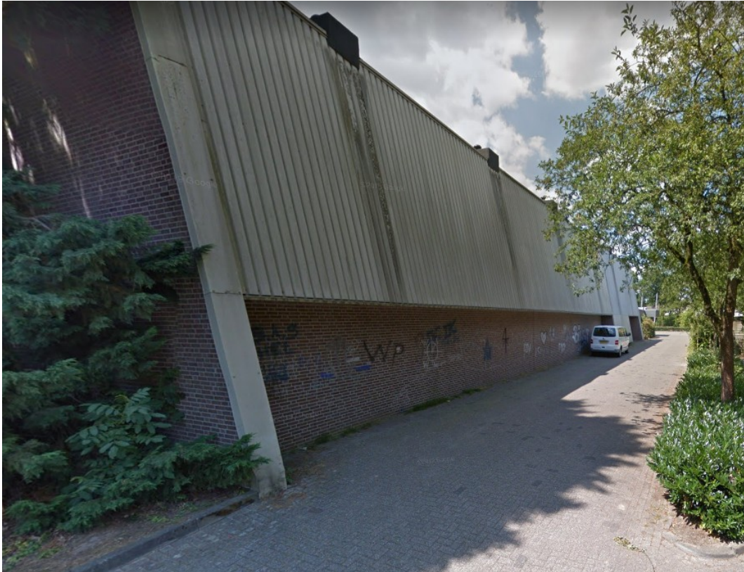
Figuur 7: Foto klinkerverharding (Google Street View).
