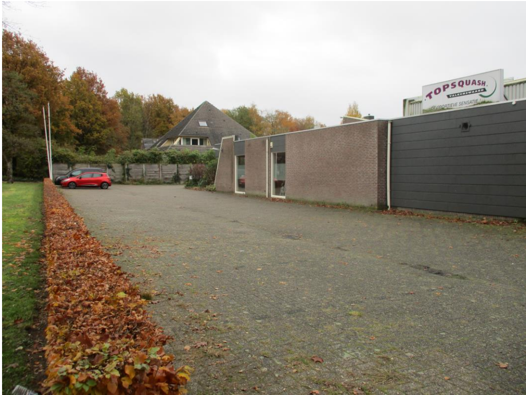
Figuur 3 De noordzijde van de sporthal en de parkeerplaats.
