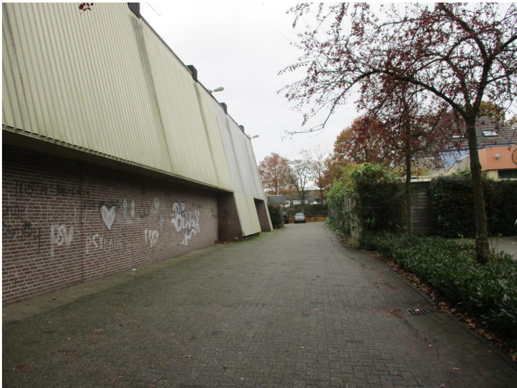
Figuur 4 De sporthal is deels opgetrokken uit gemetselde muren en bestaat deels uit damwandplaten.
