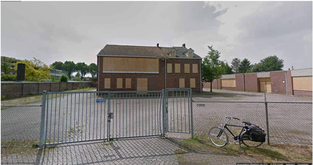
Figuur 4.1.2. In het plangebied was vroeger bebouwing aanwezig. Bron: Google Streetview.
