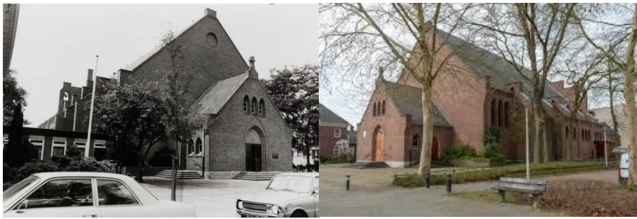
Figuur 2.6 Anthonius van Paduakerk, links foto genomen in 1981 met op de voorgrond de ingangspartij in de zuidgevel; gezien naar het noordwesten (bron: BHIC 2020). Rechts een foto uit 2019 met het ingangsportaal in de zuidgevel en de noordgevel; gezien naar het zuidwesten (bron: CRA Vastgoed).
