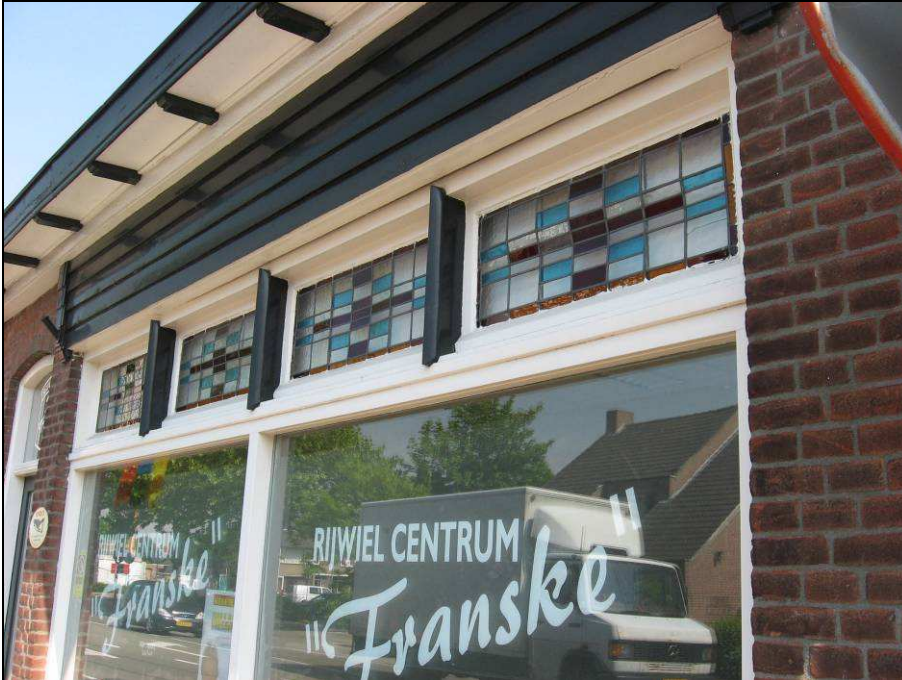
De etalagepui met glas-in-lood bovenramen, betimmering en houten bakgoot
