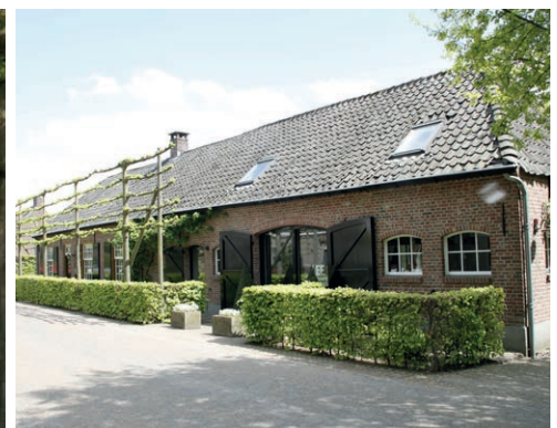
Langgevelboerderij met beukenhaag
