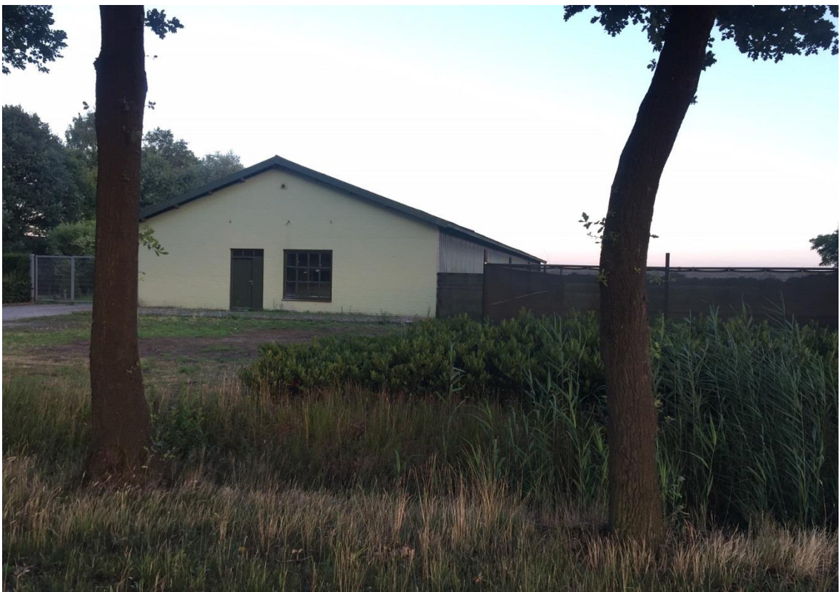
Figuur 3-2 Foto ter plekke van te realiseren rijhal aan de Peedijk 17a
