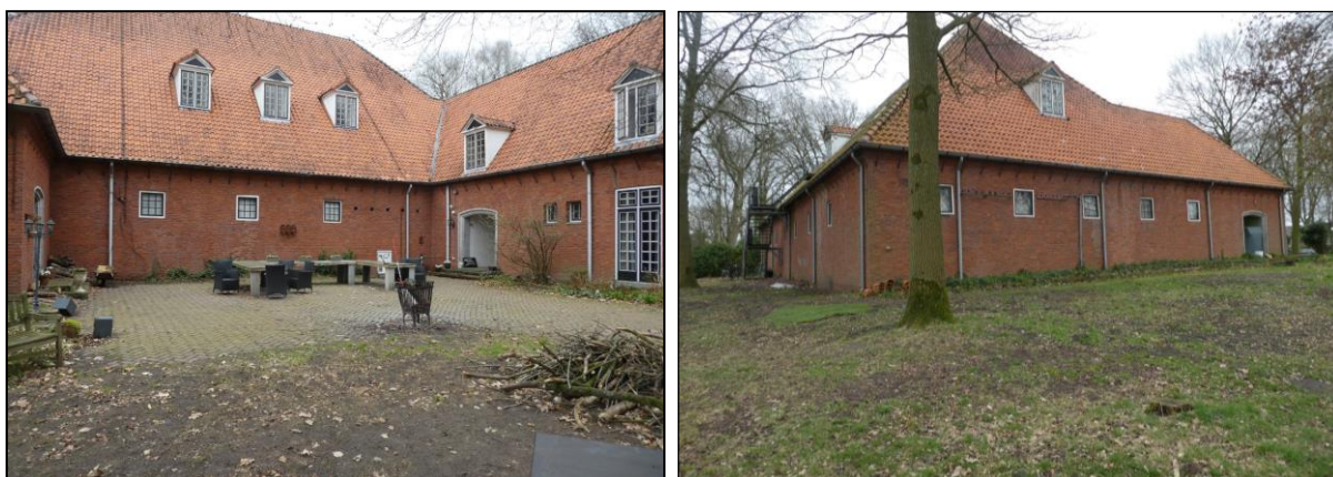
Figuur 6: Noordelijk deel van het pand, waarin de bunker is ondergebracht
