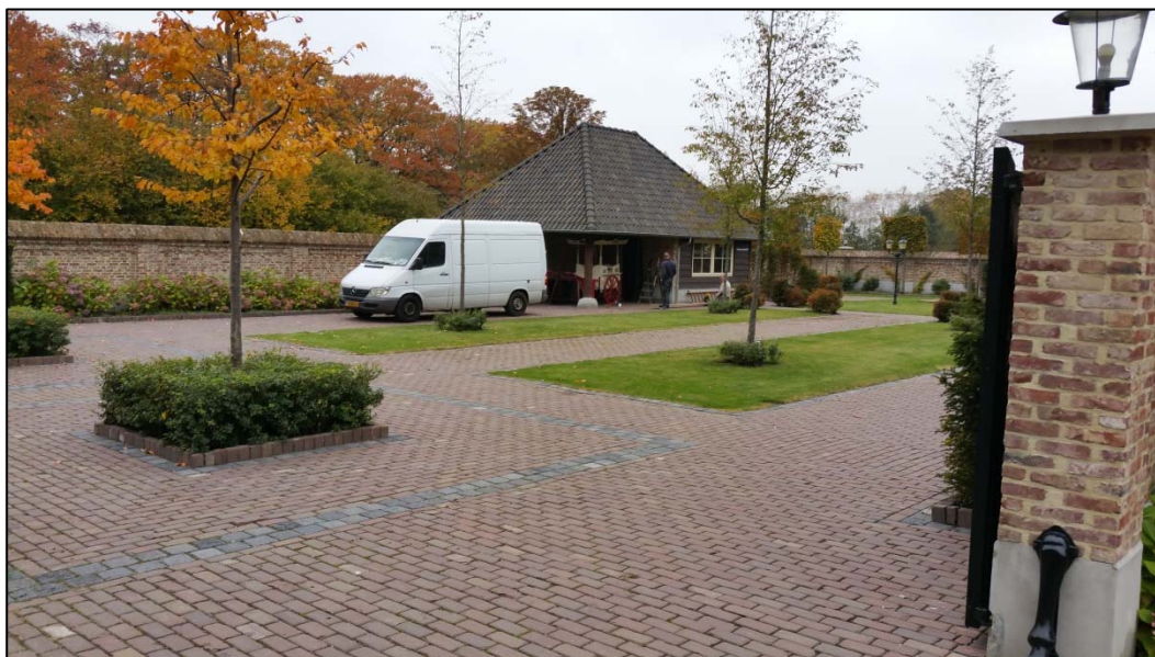
Figuur 8 beeld op de binnenplaats waar een terras wordt gerealiseerd
