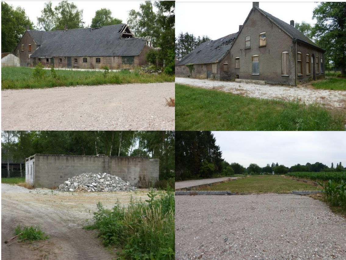
Figuur 5: Foto's van de bestaande bebouwing op de locatie. De beide bovenstaande foto's geven de huidige bebouwing van de boerderij weer. Op de onderste foto's zijn de restanten van de afgebrande veldschuur te zien en is de opslagloods in aanbouw weergegeven.
