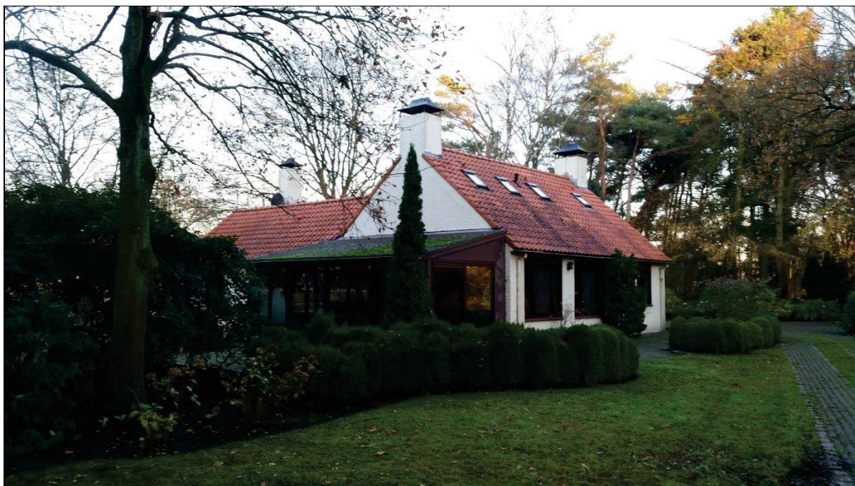
Foto 1. Onderzoekslocatie met te slopen woning
