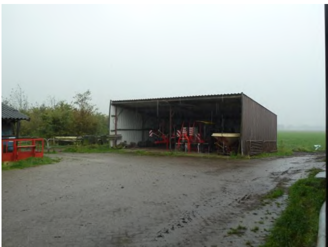
Te slopen werkplaats/berging/ opslag
