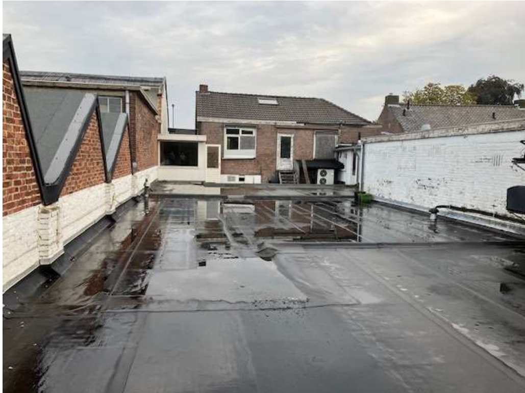
• Afbeelding 20: Breed zicht op de daken achter de discotheek, voorzien van plat dak
