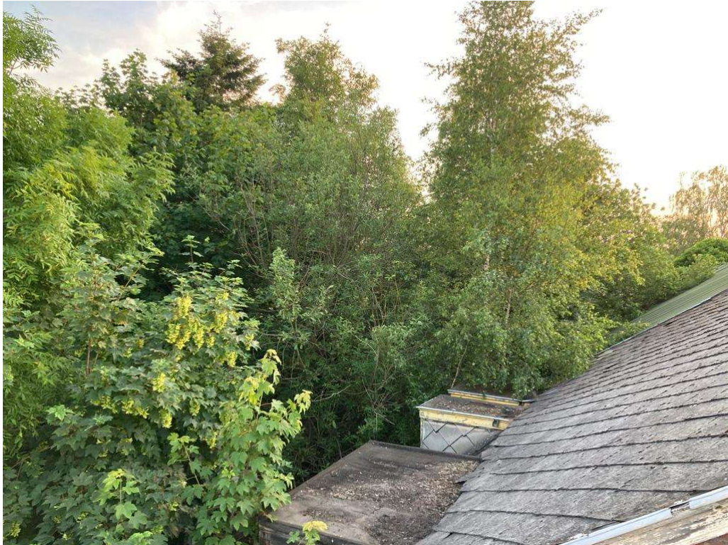
• Afbeelding 14: Dak woningen Kromstraat
