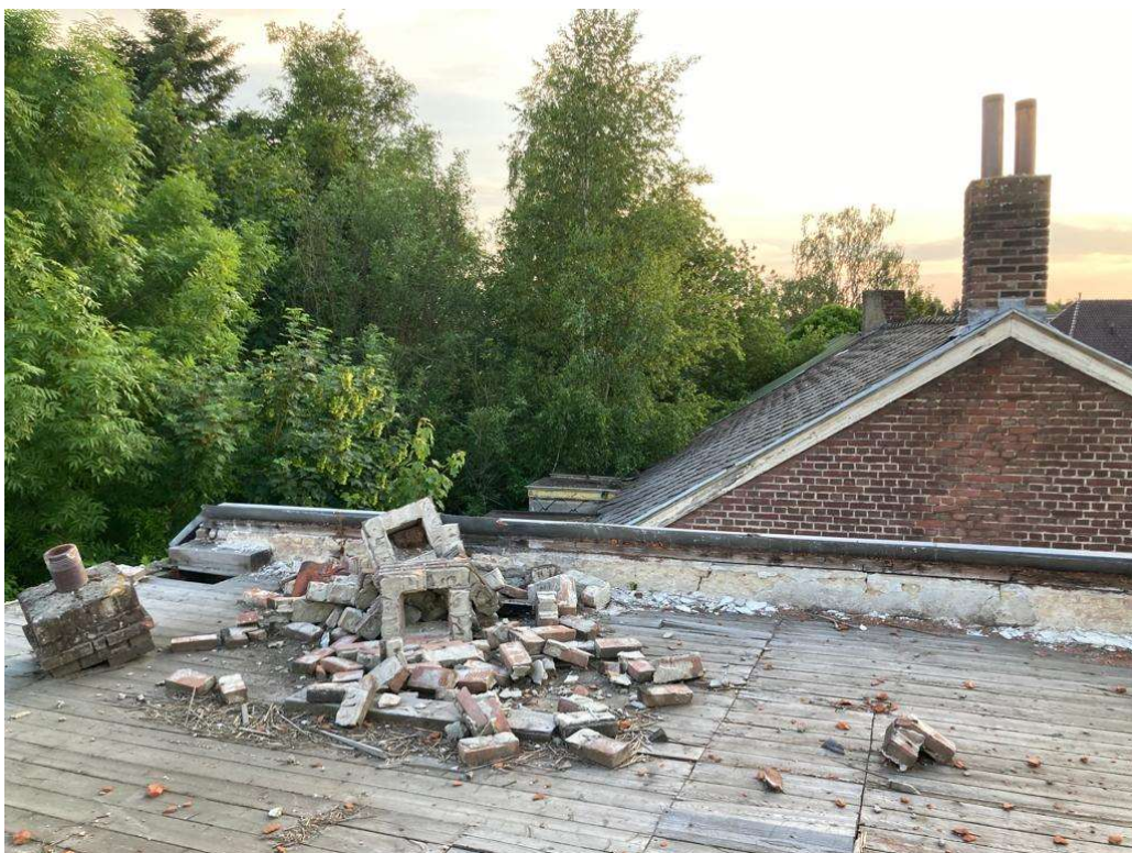
• Afbeelding 15: Dak woningen kromstraat, dakbedekking reeds verwijderd schoorsteen afgebroken
