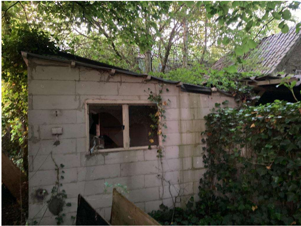
• Afbeelding 10: te slopen bijgebouw onder begroeiing
