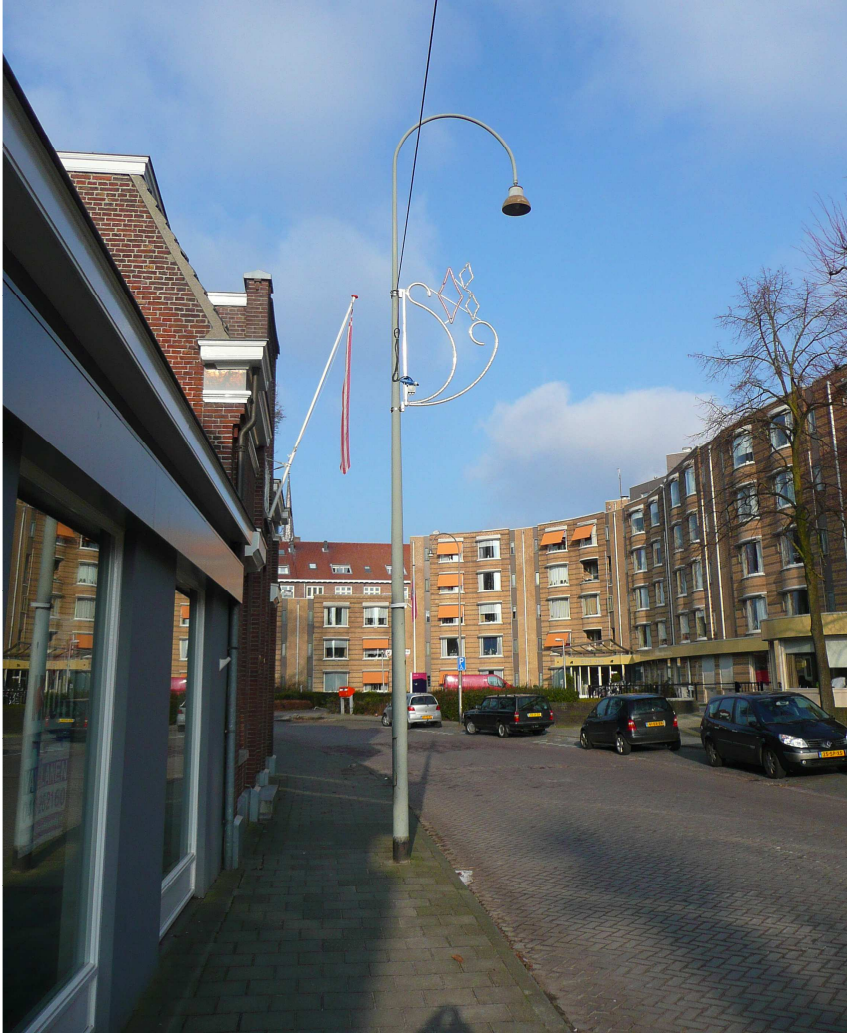
Figuur 7. Straatlantaarn uit de vroeg-naoorlogse periode, gekenmerkt door de gebogen vorm en de kapvorm waarin het armatuur bevestigd is.
