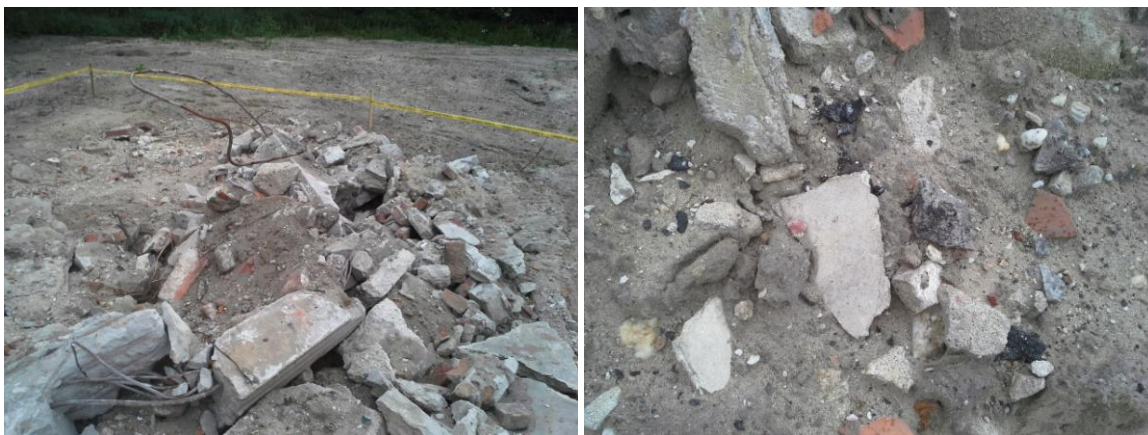
Foto's van het asbestverdachte materiaal, binnen de afgezette stukken – 16 juli 2018
