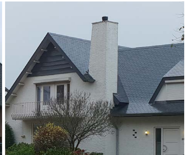
Woningen voorzien van een schoorsteen
