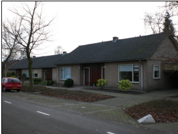
2.d huidige bebouwing Beukenlaan
