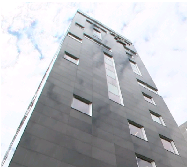
Een van de vier kantoortorens aan de Dr. Hub van Doorneweg
