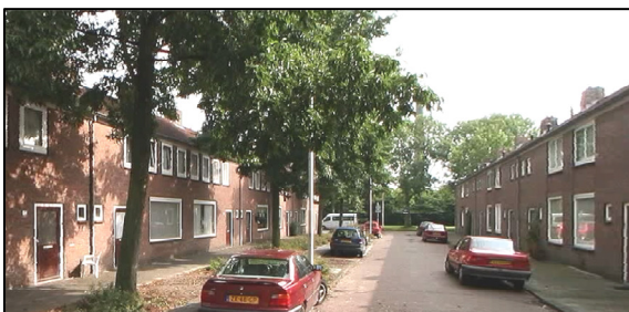
Woningen uit begin jaren '50 met asymmetrisch straatprofiel
