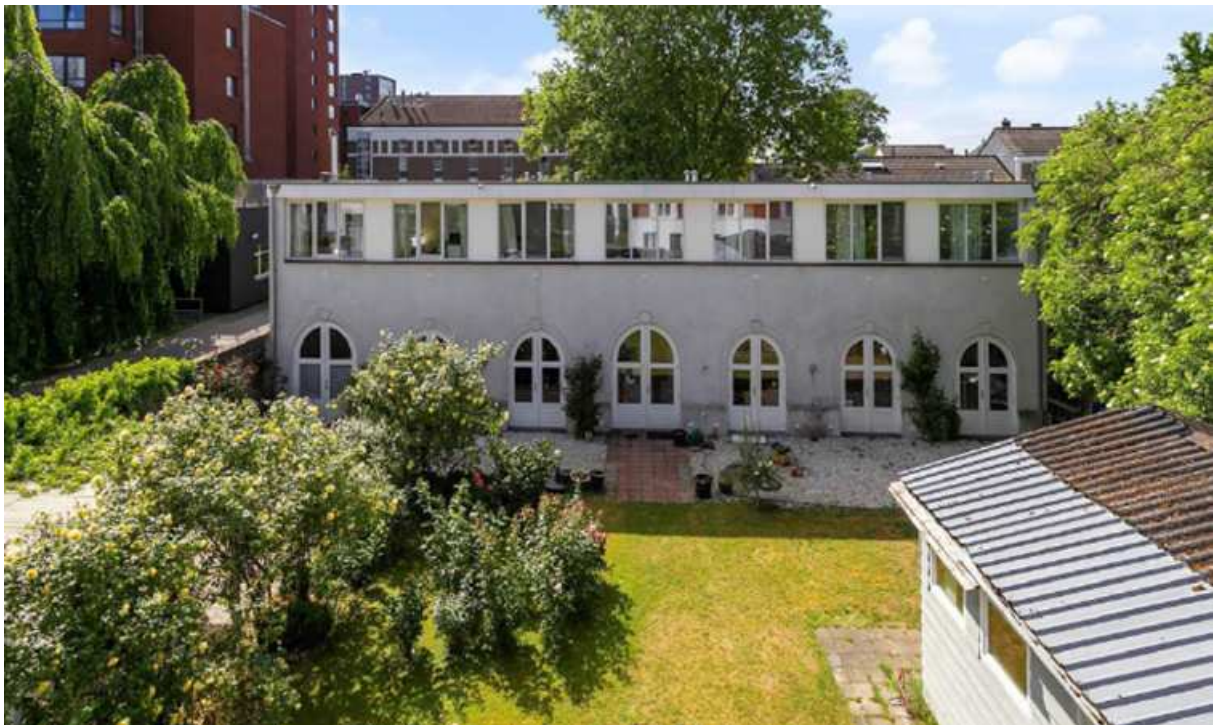
Figuur 1 – Fraterstraat 1 : Bestaand hoofdgebouw
