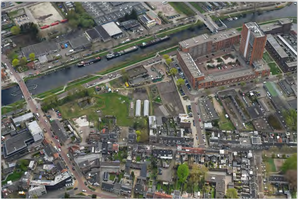
Figuur 2.3 Luchtfoto vanuit het noorden, plangebied links van het midden.
