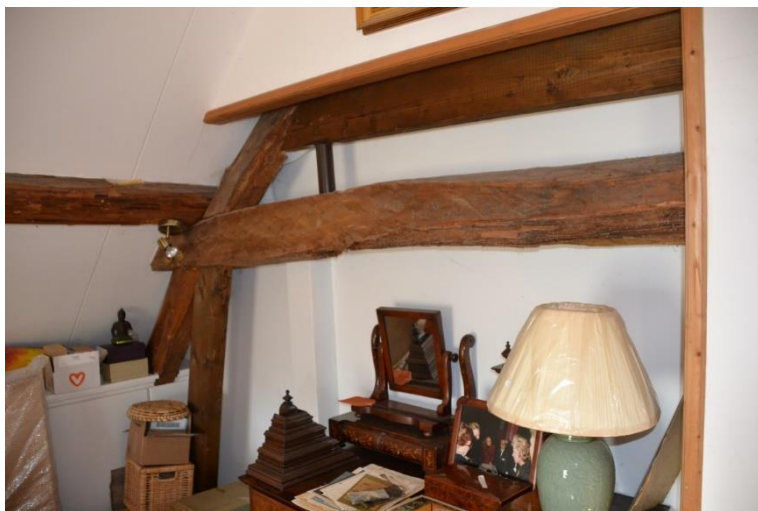
Gedeeltelijk zichtbaar dekbalkjuk met aanzet van het daarop staande spant.
