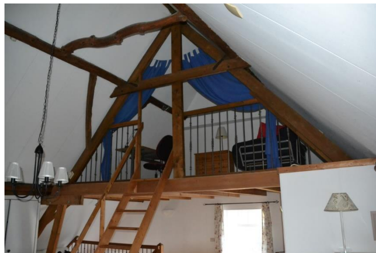
Vernieuwd spant boven het bedrijfsdeel.
