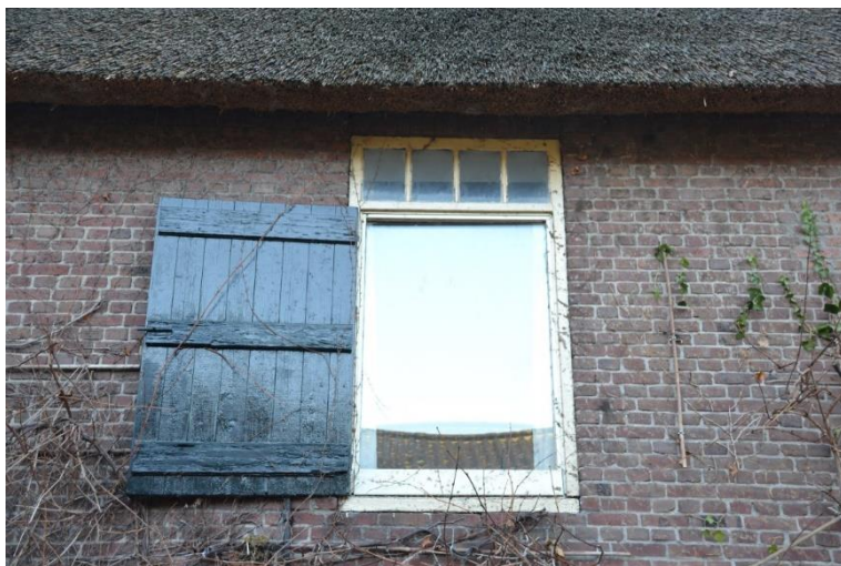
Voormalig hooiluik in de linkerzijgevel.
