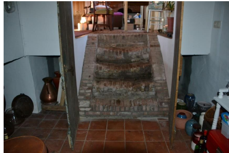
De eerste keldertoegang vanuit de kelder gezien.
