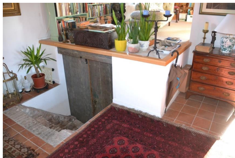
Keldertoegang met oorspronkelijke gemetselde trap.
