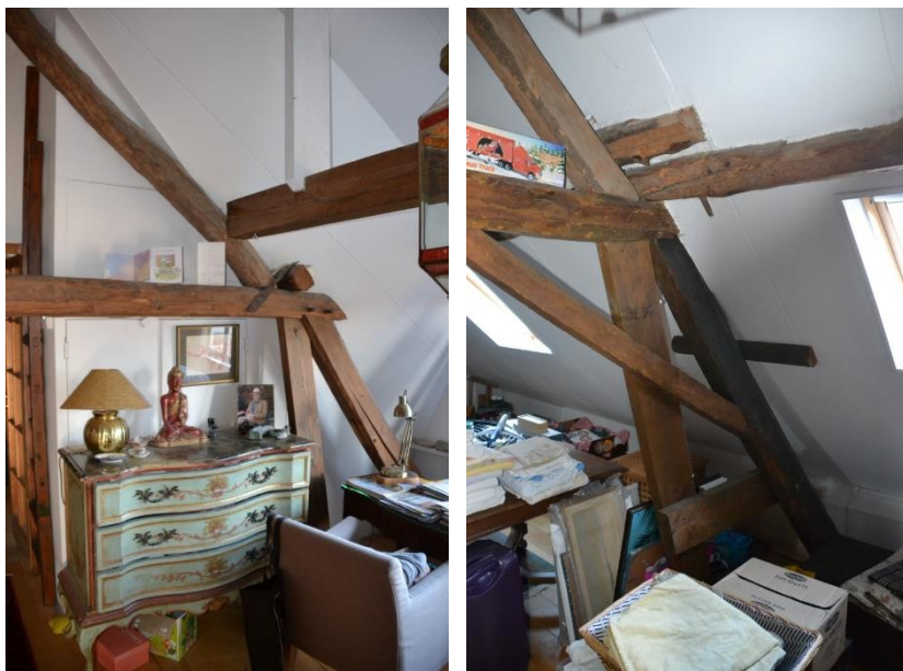
Links en rechts: dekbalkjukken met daarop de spanten.
