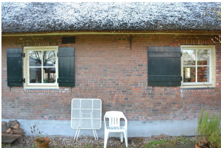
De later aangebrachte houten vensters in het bedrijfsdeel.
