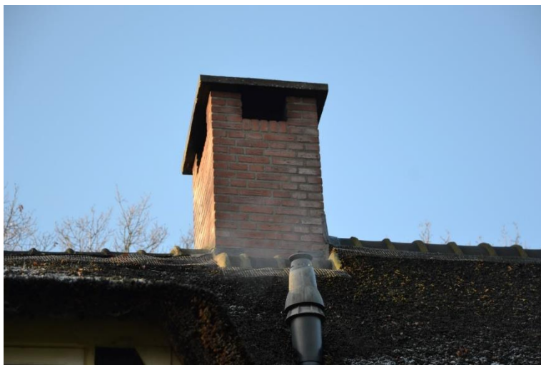
De vernieuwde schoorsteen.
