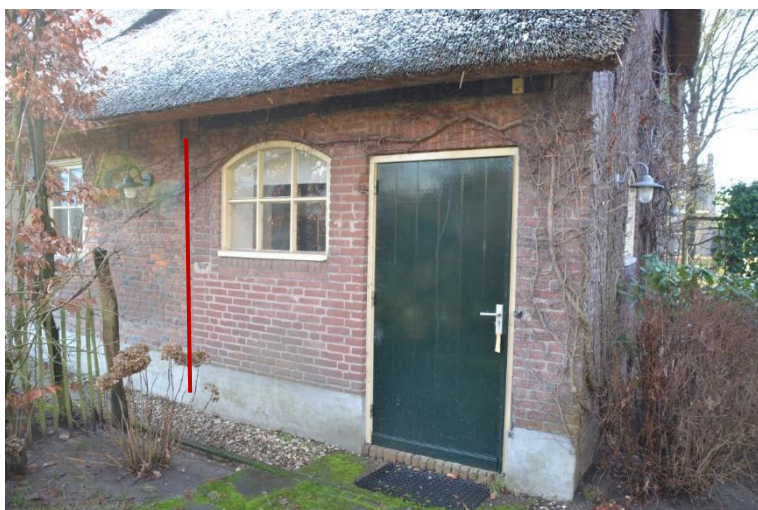
Het meest rechtse en vernieuwde geveldeel. T.h.v. de rode lijn het bouwspoor.
