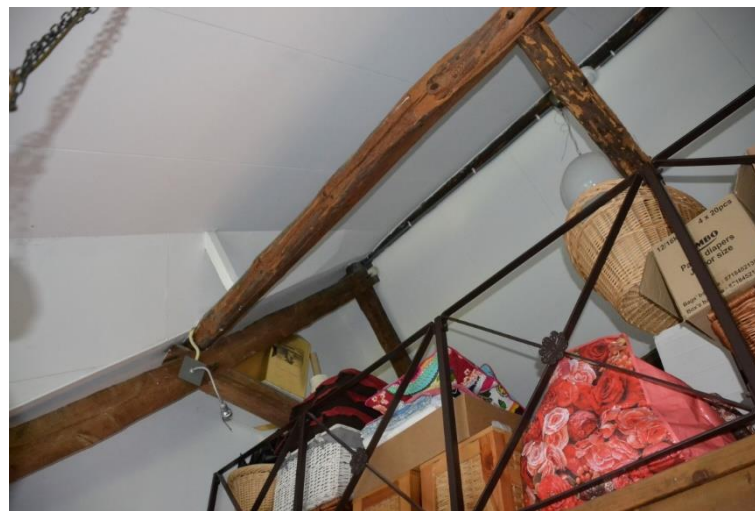
Een van de A-spanten met de oorspronkelijke gording en extra hanenbalk.
