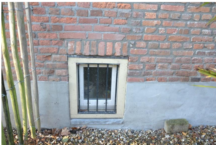
Eén van twee kelderlichten.
