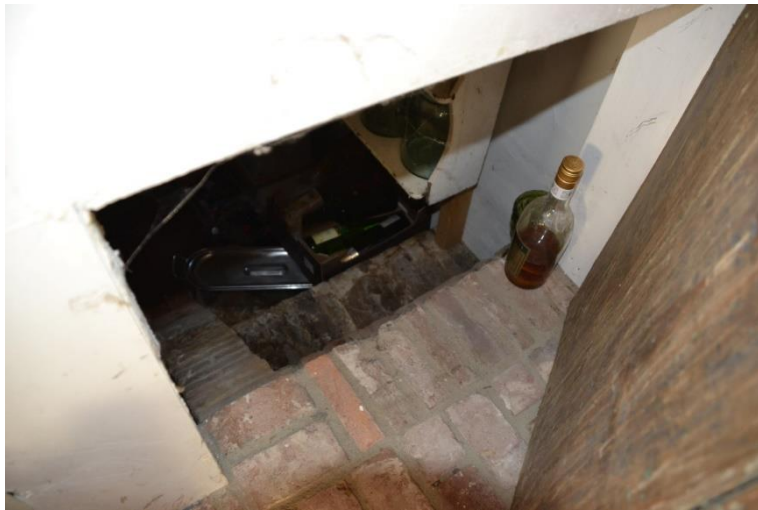
De tweede keldertoegang met eveneens gemetselde trap.
