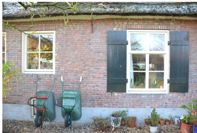
Eén van de twee opkamerramen en het woonhuisvenster.
