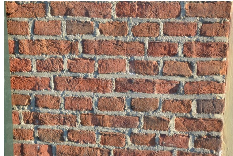
Detail van het metselwerk, vermoedelijk gezandstraald en opnieuw gevoegd.
