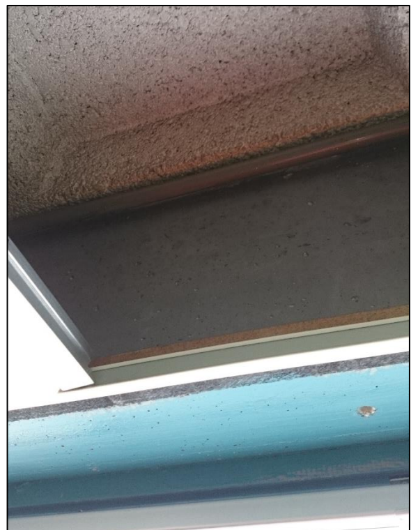
Afbeelding 4: Dakconstructie van pand D waarbij het beton van het dak direct bovenop een staalbalk ligt.
