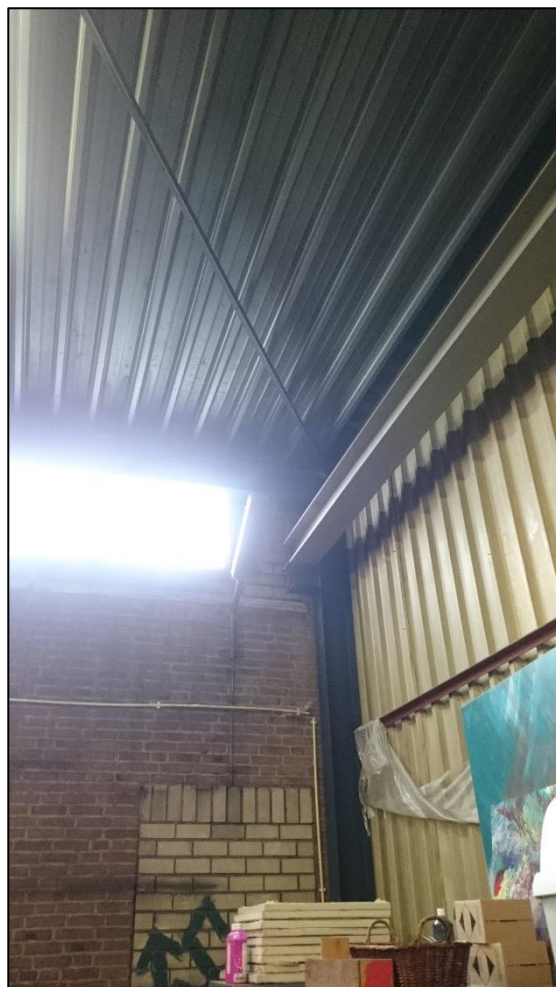
Foto 4: Binnenzijde bedrijfshal C (Dewy Baak ART). Damwandplaten zijn van binnenuit niet bekleed.
