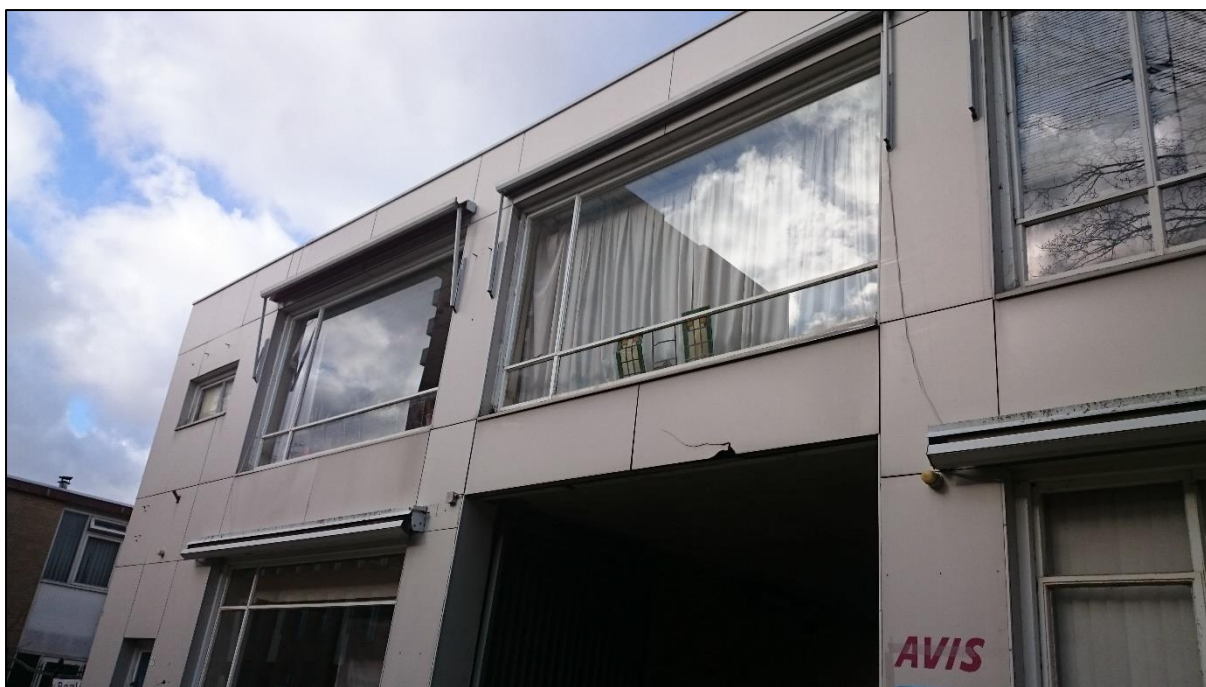
Foto 8: Voorzijde woningen F. De gemetselde muur is bekleed met dun plaatmateriaal.
