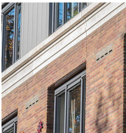
Afbeelding 6: Inbouwstenen van het type- IB VL 01 die gebruikt kunnen worden als permanente verblijfplaatsen voor vleermuizen. Links de losse steen met ingang en een tussensteen. Rechts de ingebouwde stenen met ingang met daar tussen een inbouwsteen zonder ingang in de spouw ( www.vivarapro.nl ).
