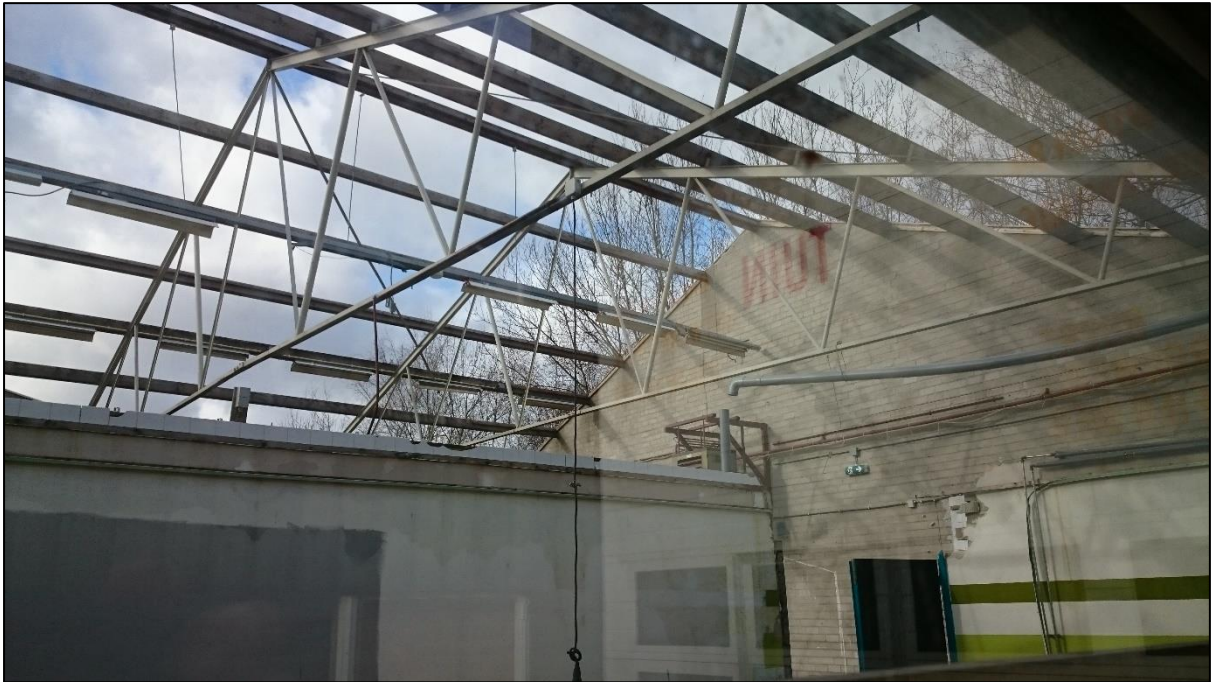
Foto 1: Bedrijfshal (A, afbeelding 3) waarvan het dak al geheel verwijderd is. Alleen kale muren en inpandige muren van begaande grond zijn nog aanwezig.
