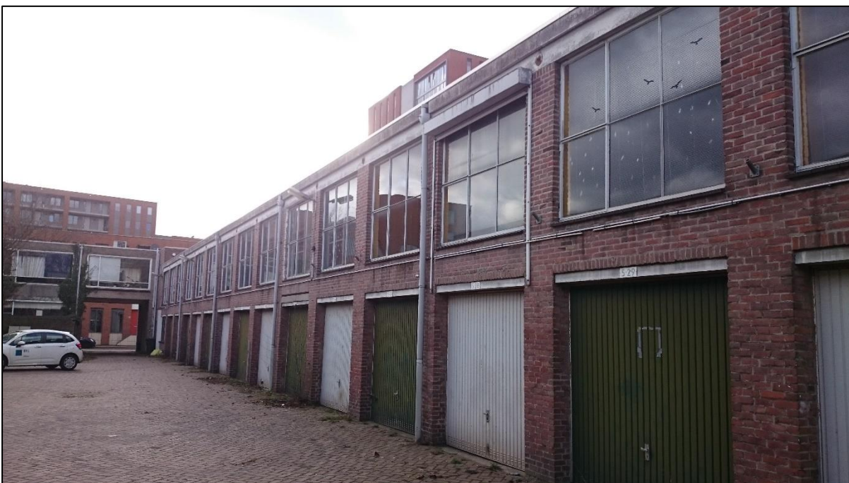
Foto 5: Pand D bestaande uit garageboxen met daarboven bedrijf-/kantoorruimtes.
