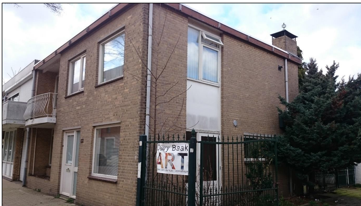
Foto 6: Rechter gedeelte van woningen E. Spouwmuur aanwezig met stootvoegen.
