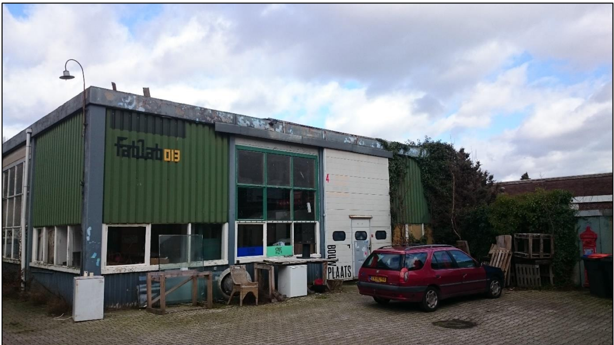
Foto 2: Bedrijfshal B (Bouwplaats) muren bestaande uit damwandplaten.
