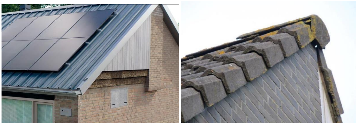
Figuur 6: Voorbeelden vleermuis voorzieningen. Links: Ingemetselde kasten, opening achter gevelplaten. Rechts: Ruimtes onder dakpannen en toegang tot spouw voor vleermuizen.
