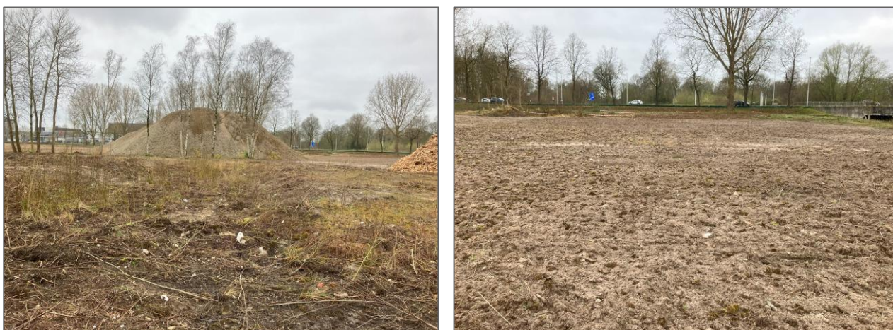
Figuur 3.1 geklepelmaaid perceel met enkele bomenrijen en opslag van betonpuin (links) en gefreesde bodem (rechts)
