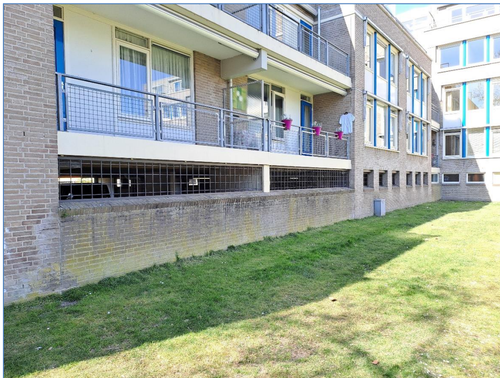
Afbeelding 9. Zicht op openingen naar de parkeergarage.
