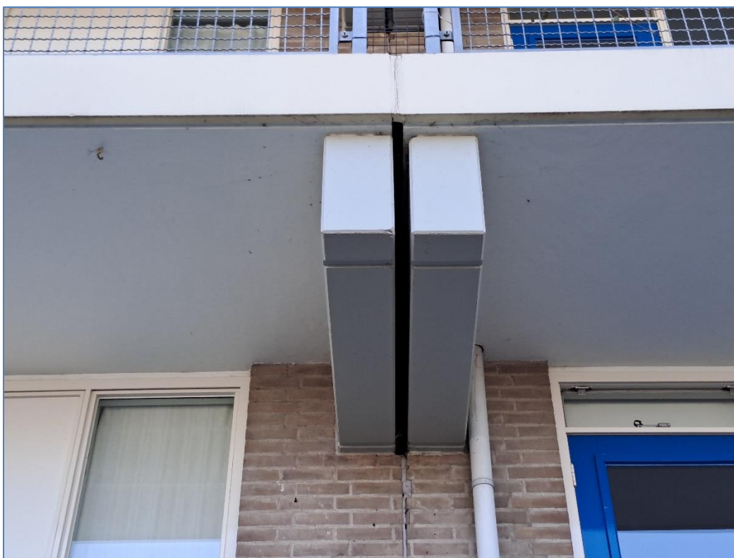
Afbeelding 14. Voeg tussen balkonspanen.
