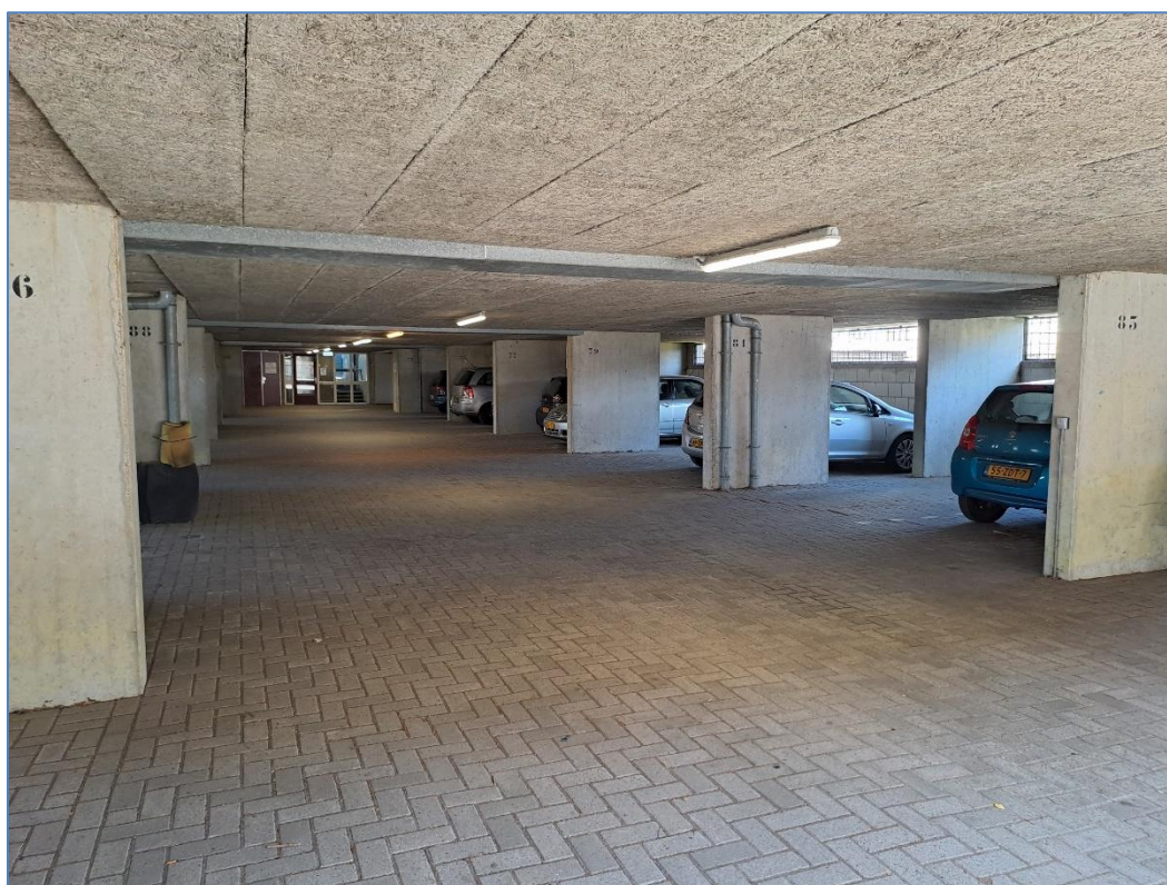
Afbeelding 8. Parkeergarage onder het appartementencomplex.
