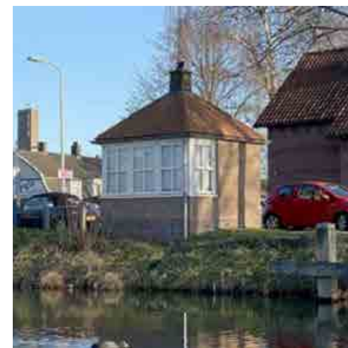
4 Wachthuisje 1923 Het wachthuisje bij de brug behoorde bij de brugwachterswoning. Het gebouwtje wordt nog steeds gebruikt. De brugwachter bedient vanaf hier twee bruggen.
