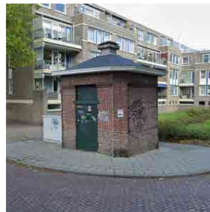
3 Transformatorhuisje 1923 Nabij het Voetboogplein staat een transformatorhuisje.
