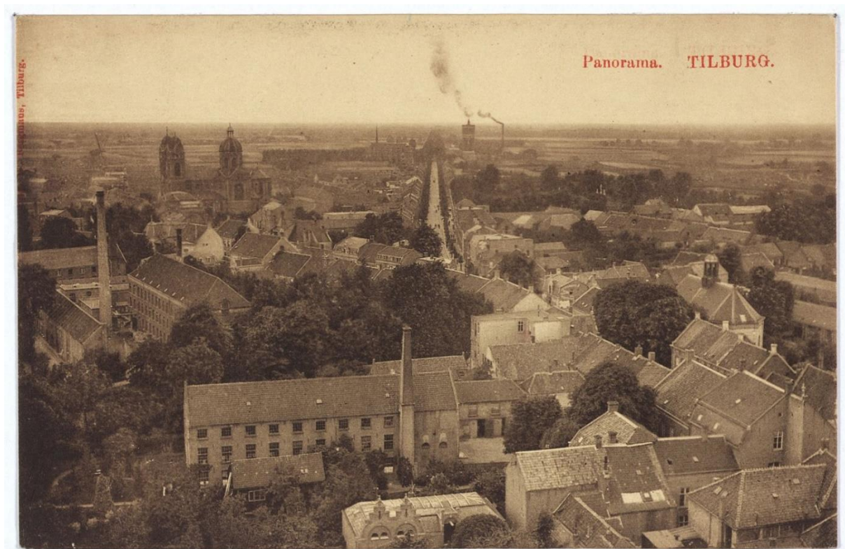
Afb. 2.8 Overzichtsfoto van het plangebied uit omstreeks 1900. De wollenstoffenfabriek van Straeter ligt links (U-vorm), vooraan was de wollenstoffenfabriek van J. de Beer net buiten het plangebied gelegen (Regionaal Archief Tilburg 2025, foto 3080).
