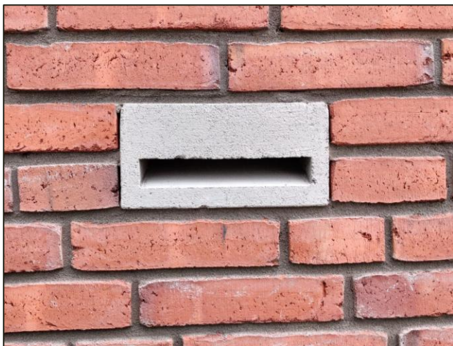
Figuur 5.2. Toegangssteen voor toegang tot spouwmuur (bron: unitura.nl).
