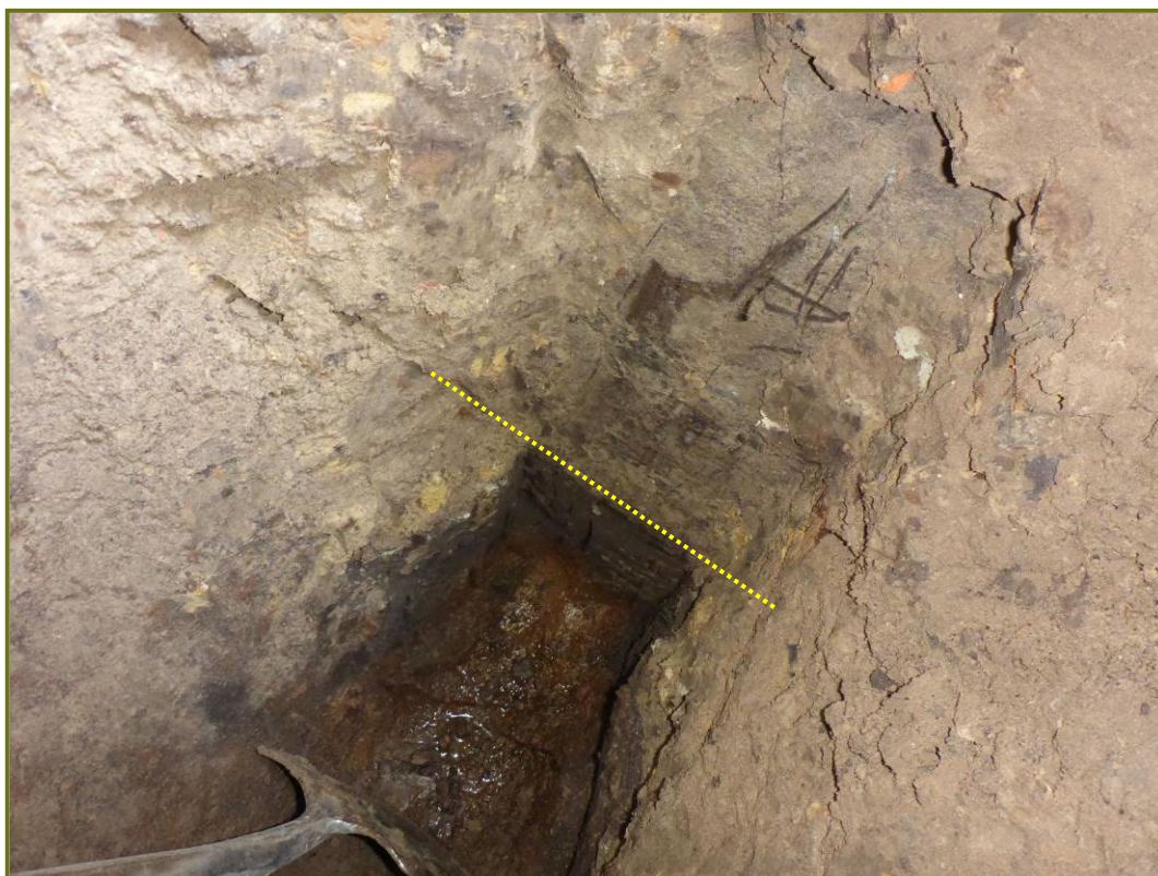
Afbeelding 35. Einde muur op -1,6 m, zie gele stippellijn
