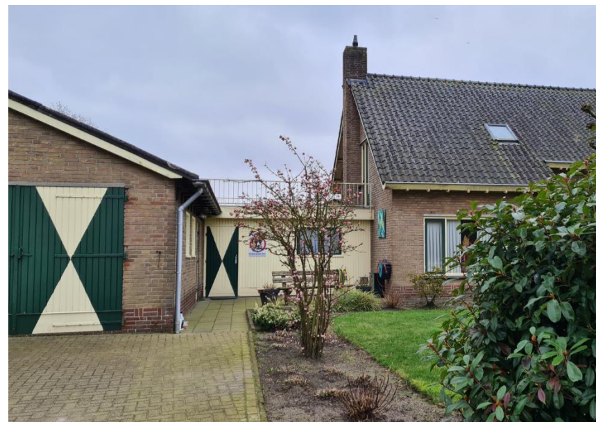
Figuur 4: Woning en naastgelegen schuur gezien vanaf IJpelareweg
