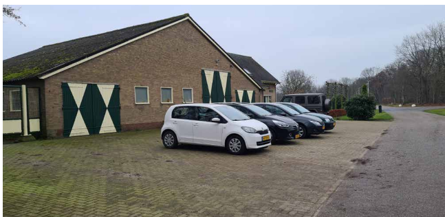
Figuur 11: De te slopen boerderij aan de IJpelareweg
