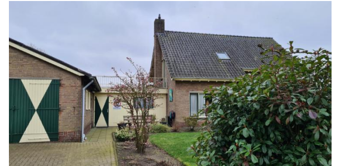
Figuur 5: Woning en naastgelegen schuur gezien vanaf IJ 5.1.2e
