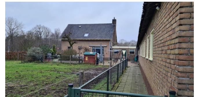
Figuur 9: Woning en bijbehorende schuur gezien vanuit zuiden
